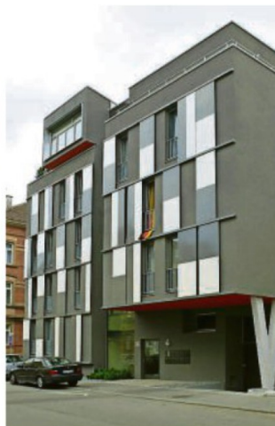
Durchdacht: Ein markantes Wohnhaus in der Heilbronner Bahnhofsvorstadt.
