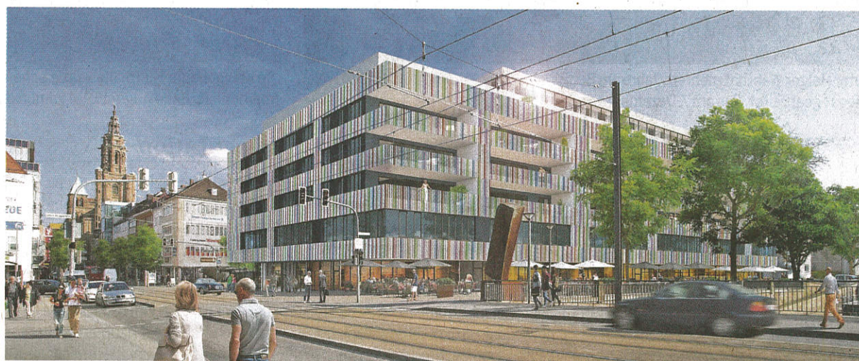
Ein Haus der vielen Gesichter entsteht an der Stelle des früheren C & A an der Kaiserstraße und am Neckarufer. Durch 17 000 farbig lackierte Aluprofile entsteht eine dreidimensionale Struktur.
