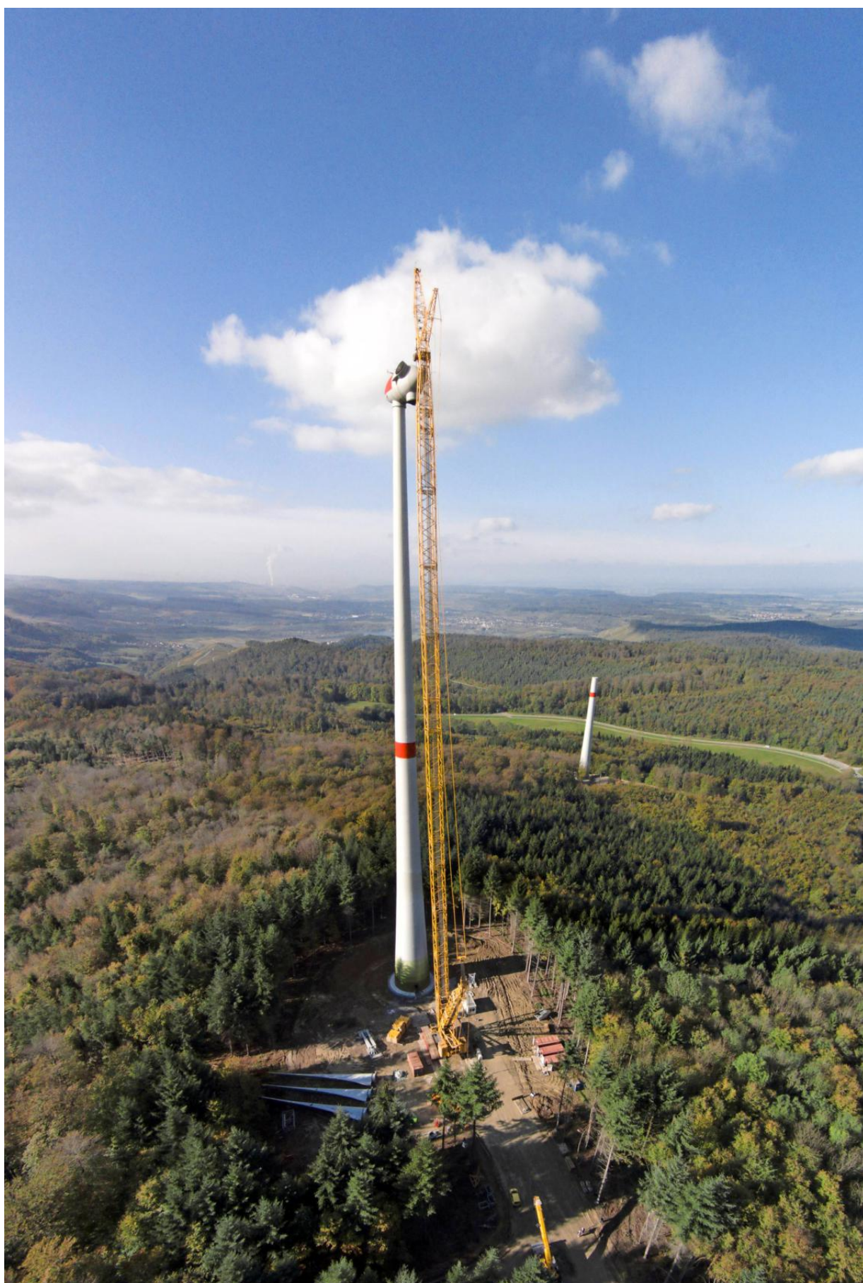
Ein Foto von der neuen Kameradrohne der Heilbronner Stimme: Im Zusammenspiel von Monteuren und Kran wird die Gondelabdeckung angeschraubt. Für die Montage der Rotoren war es am Freitag zu windig. Fotos: Manuel Maier, Dennis Mugler
