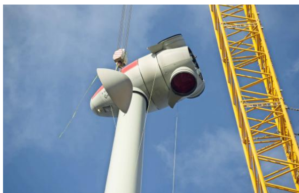
Vorsichtig bringt der 600-Tonnen-Kran die Gondelabdeckung auf 140 Meter Höhe.
