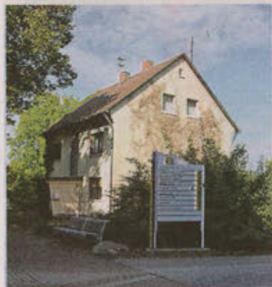
Das Illerhaus-Gelände soll noch in diesem Jahr geräumt werden.
