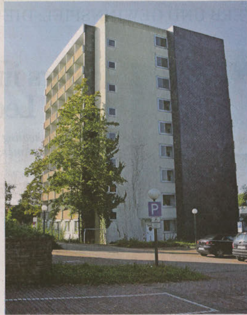
Bis Sommer soll das Gebäude der alten Rosentrittklinik abgerissen werden: Es steht seit nunmehr zehn Jahren leer.
