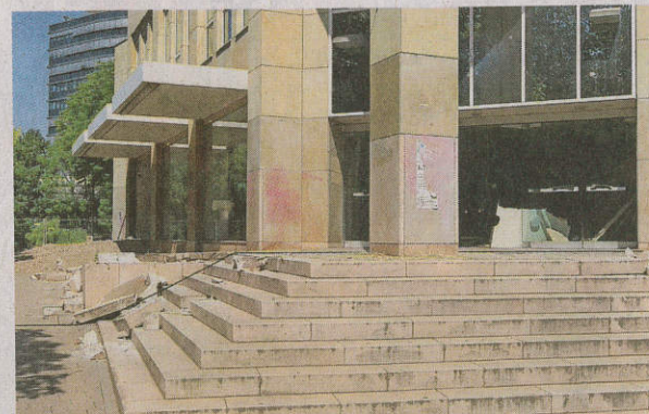
Das ehemalige Kaufhaus C&A wird gerade entkernt. Der Abriss wird bis November dauern. Foto: Andreas Veigel
